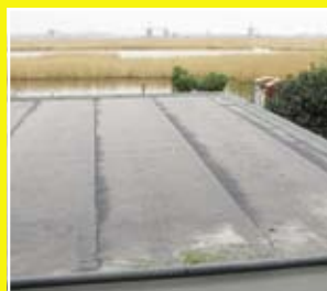
Het dak voor de renovatie
