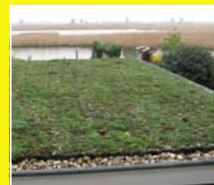
Het eindresultaat, direct een groen dak met MobiRoof
